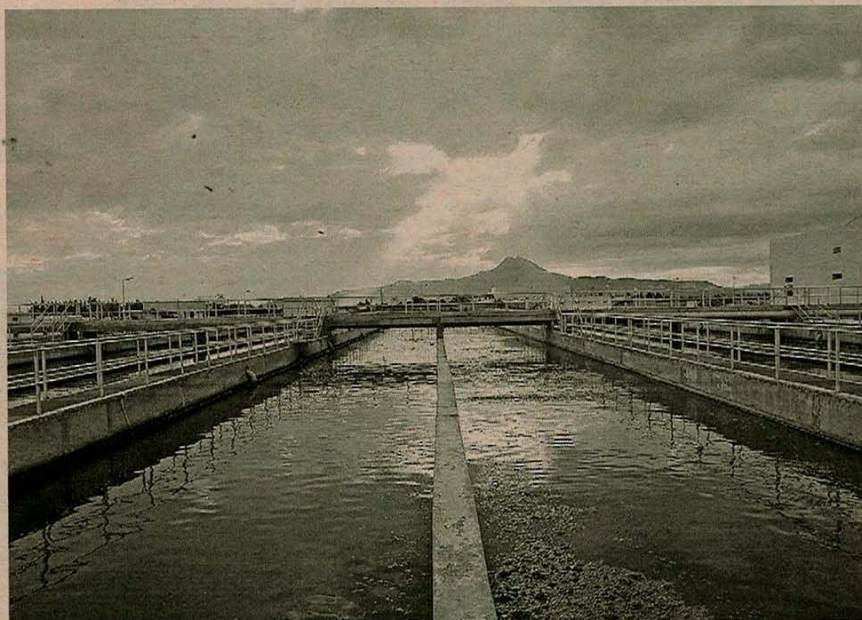
Estación depuradora de Dytras.
